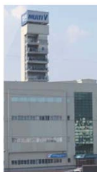
Testy długości instalacji
